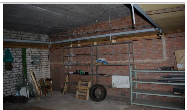
Фотография 3.4. Внутреннее помещение объекта
