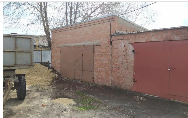
Фотография 3.1. Внешнее состояние объекта
