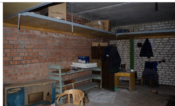
Фотография 3.3. Внутреннее состояние объекта
